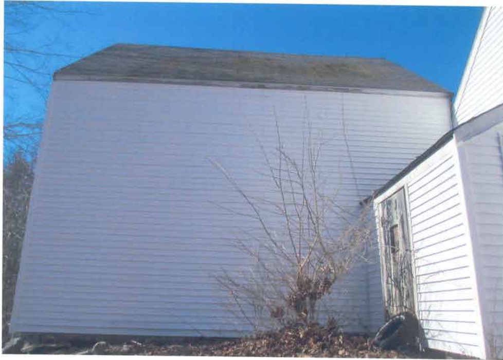
101 Mill Rd. - Left Side
